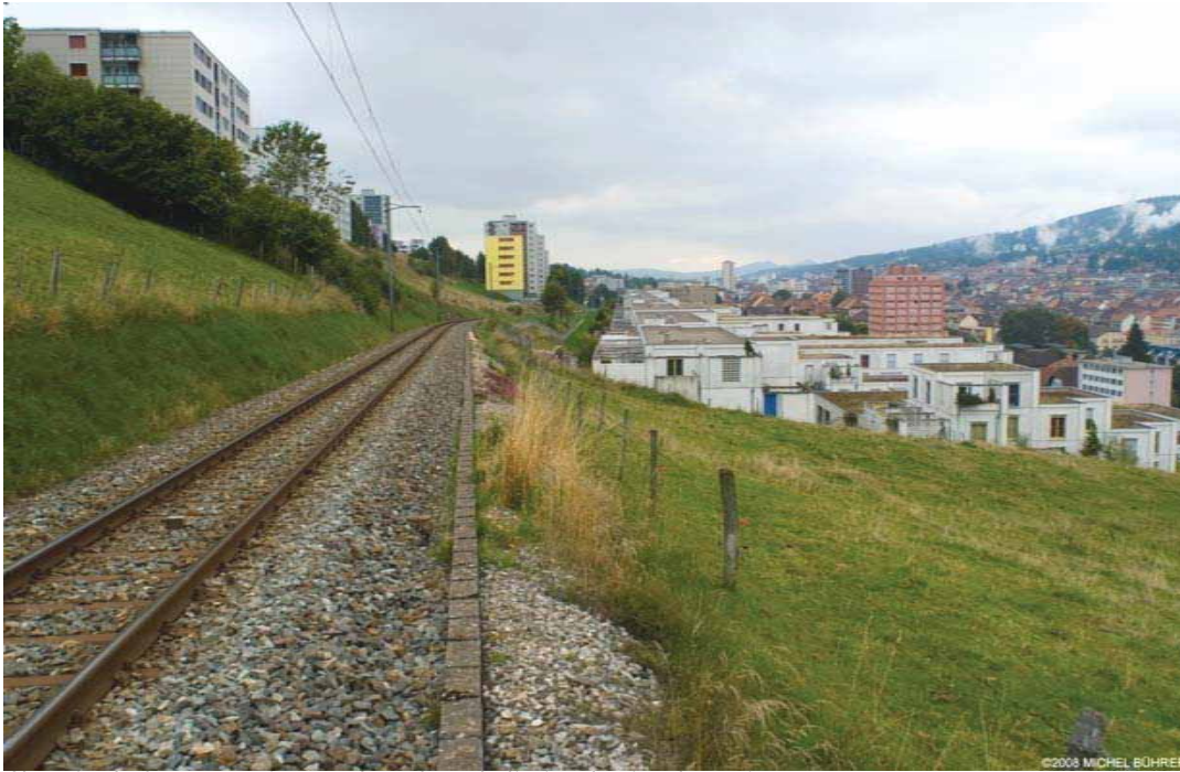
Chemin de fer + quartier "Esplanade" à la limite du site de projet
